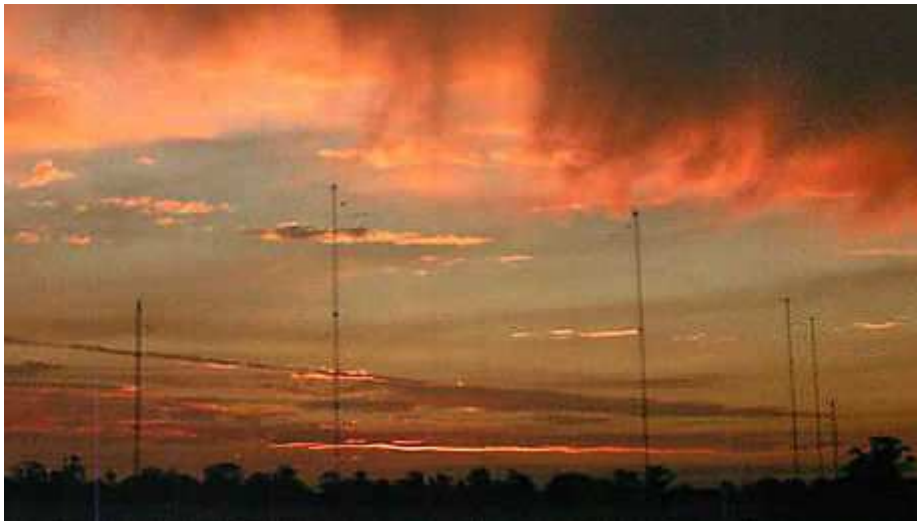
Sendeanlage Shepparton bei Melbourne (Quelle: Radio Australia, 2004)
